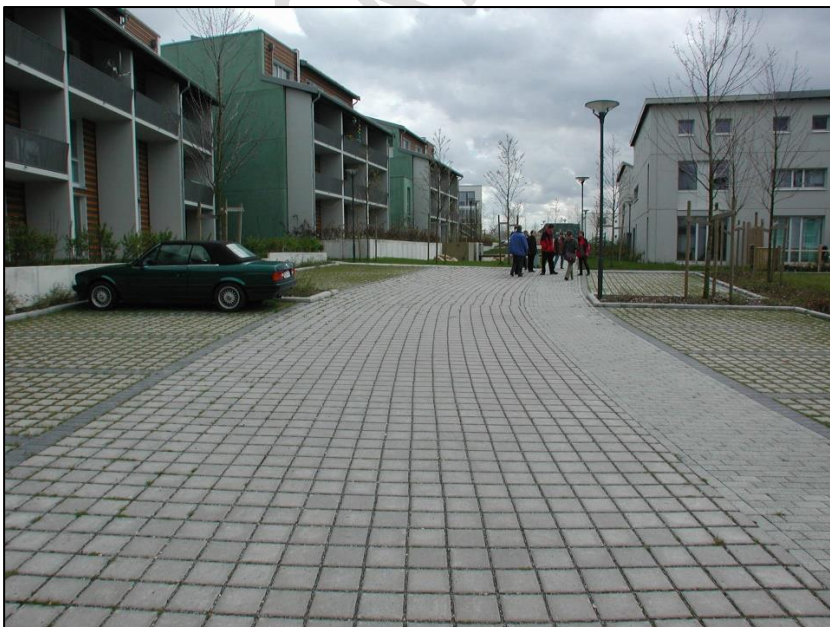
Figur 21. Parkering och gata med genomsläpplig beläggning (Foto: Norconsult)
