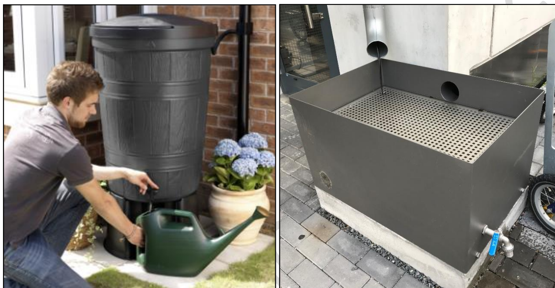
Figur 22. Till vänster regnvattentunna för magasinering av dagvatten (Foto: Bauhaus). Till höger s.k. regnskördartunna i Norra Djurgårdstaden (foto: Norconsult)
