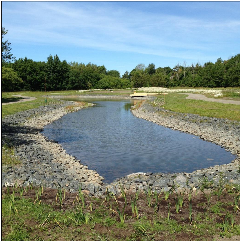
Figur 14. Exempel på dagvattendamm i Trönninge i Varberg. Foto: Norconsult
