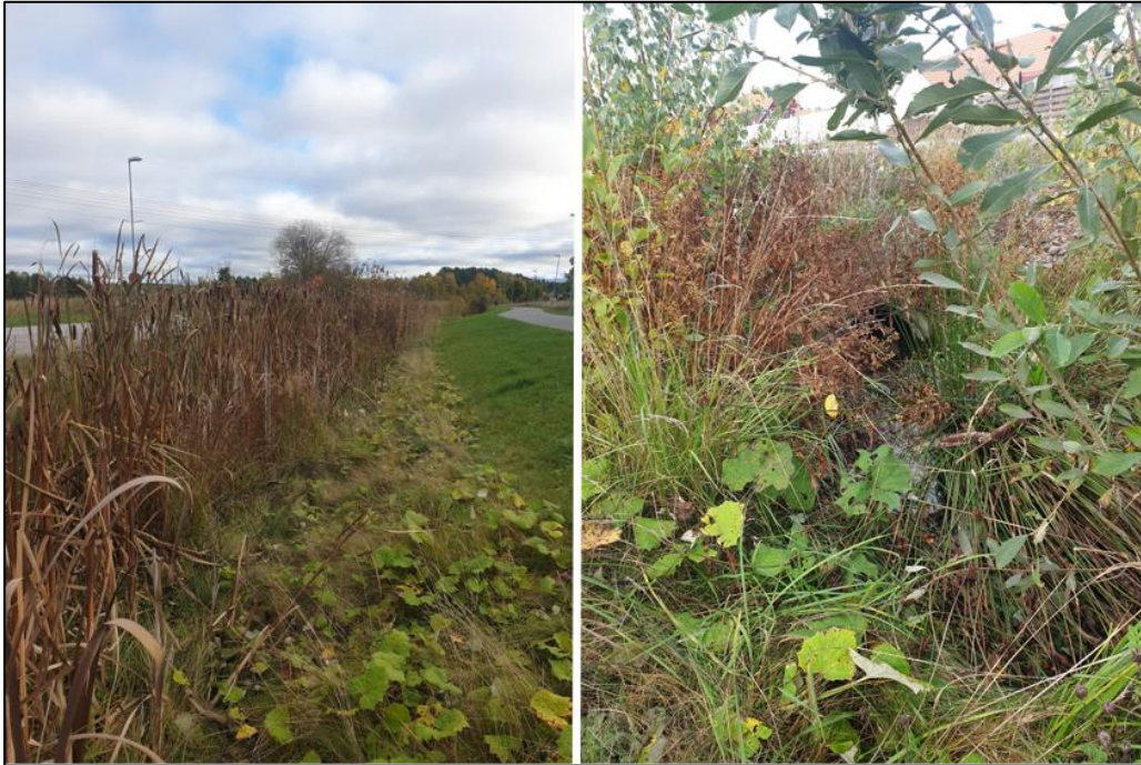
Figur 11. Utlopp till diket som avleder dagvatten från befintligt bostadsområde till dammen
